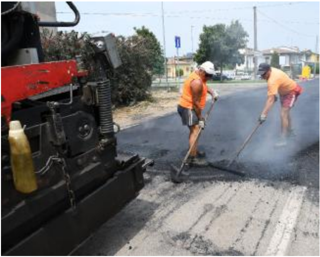
Mezzi e operai al lavoro in questi giorni in tutta Lumezzane
