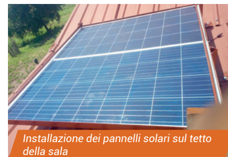
Durante il montaggio del sistema solare
